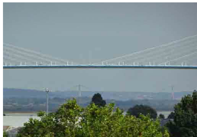
Le pont de Normandie
